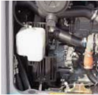
ラジエーターバタンク
