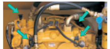
ポンプなど各所に設置された圧力検出タップ
